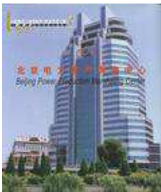
北京电力生产调度中心
